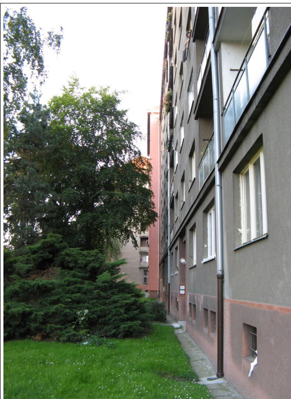
Obr. 2.1.2 – zadní pohled na budovu
